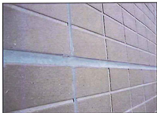
経時で劣化したビルの目地部
